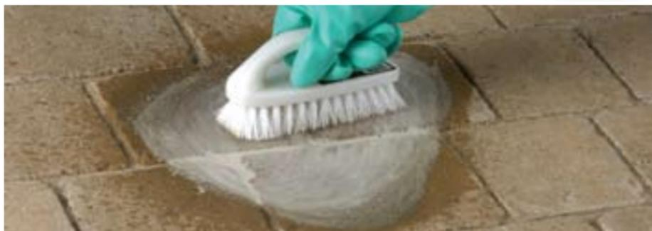
En remontant la pente, enlever une à une les taches d'huile, de rouille, de peinture, de goudron, etc. à l'aide des produits appropriés. Au besoin, enlever la mousse à l'aide du DÉMOUSSANT.
