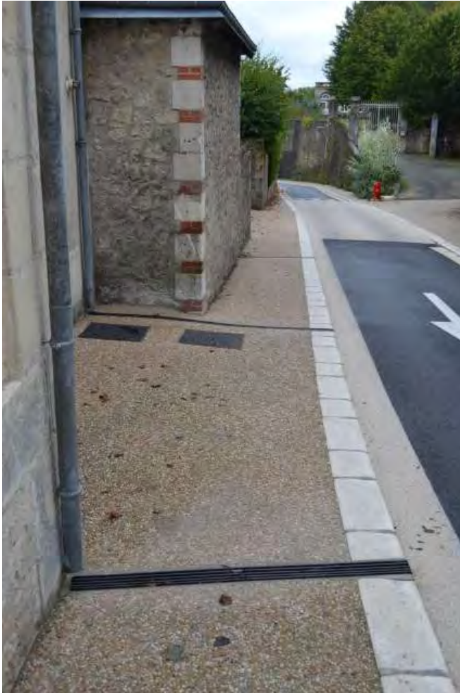
Montlouis s/Loire (37) – La Chaussée St Victor (41) – Descentes de gouttières
